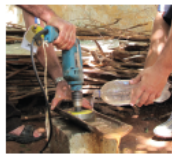
A esquerda, furando a telha com o auxílio de uma furadeira. A baixo, as novas telhas com a lâmpada solar prontas para serem no telhado.
