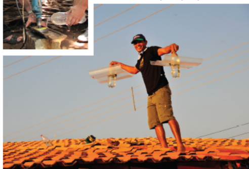
A esquerda, furando a telha com o auxílio de uma furadeira. A baixo, as novas telhas com a lâmpada solar prontas para serem no telhado.
